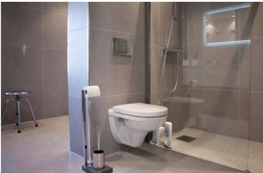
Kirsten har valgt sandfargede fliser i ulike størrelser. Ettersom det kan være vanskelig å få til riktig helning i gulv med de største flisene, har Kirsten fått veggene dekket med 60 x 60 fliser, mens gulvet er kledd i fliser på 30 x 30. I dusjen er gulvet flislagt med mosaikk.
