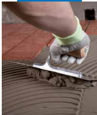
Påføring av Elastorapid på terrasse vannrettet med Mapelastic
