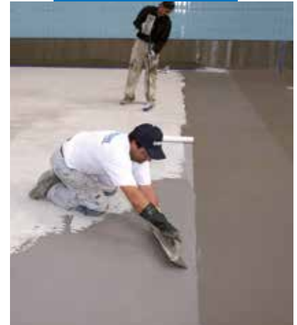
Vanntetting av svømmebasseng med Mapelastic
