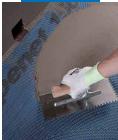
Påføring av Mapelastic over Mapebet 150
