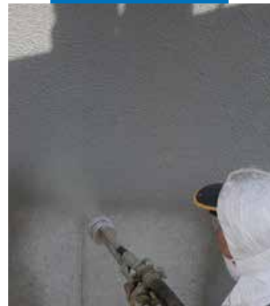
Påføring av Mapelastic med sprøyte på bru
