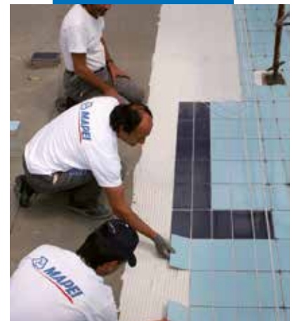
Legging av fliser med Mapelastic i svømmebassen
