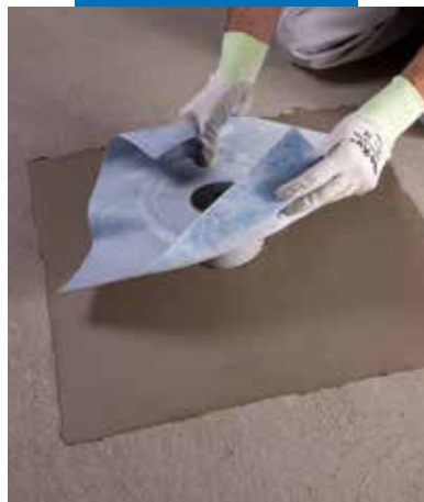
Installering av slukmansjett med Mapelastic
