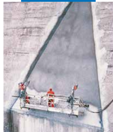
Påføring av Mapelastic med sprøyte på damanlegg
